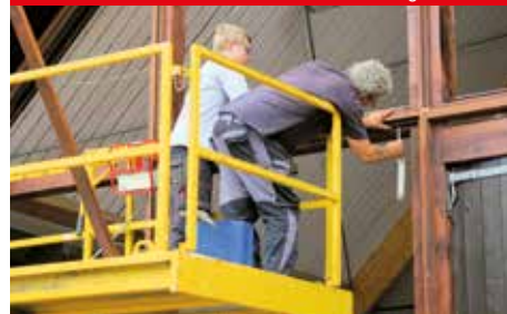
Anbringung der Holzleisten für die neuen Fenster
