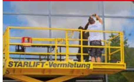
Verschraubung der Metallblenden für die neuen Fenster
