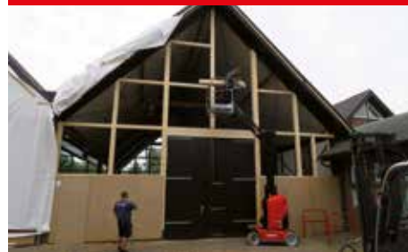
Die Außenfassade mit neuen Ständern und Riegeln
