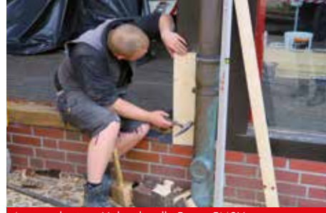
Austausch eines Holzteils, alle Fotos: FMSH
