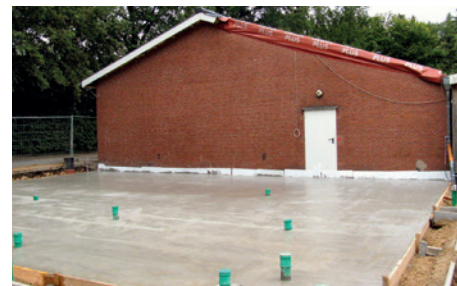
Fundament des erweiterten Feuerwehrhauses
