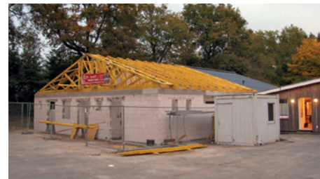
Wände und Dachstuhl des erweiterten Feuerwehrhauses
