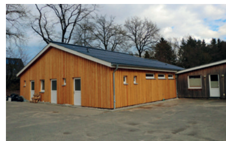
Außenansicht des erweiterten Feuerwehrhauses
