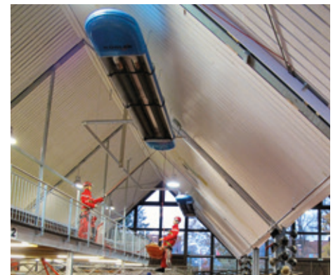
Infrarotstrahler in der Spender-Halle, Foto: FMSH
