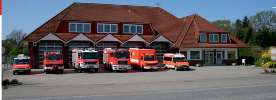
Feuerwehrhaus der FF Bönningstedt, Foto: sb
