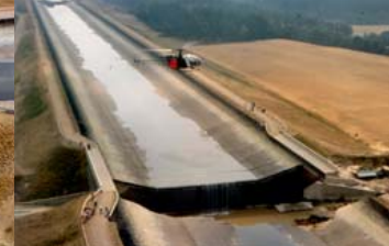
Der Kanal ist durch zwei künstliche Dämme (am oberen Bildrand) soweit abgedichtet, dass keine Wassermassen mehr nachströmen können, Foto: mg
