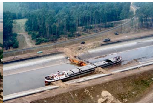
Mithilfe eines Frachtschiffes, Sandsäcken und großen Erdmassen wurde ein erster provisorischer Damm errichtet, um die Fließgeschwindigkeit zu verringern, Foto: mg
