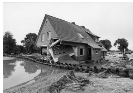
Eines der von den Flutmassen schwer beschädigten Wohnhäuser in Stadtfeld-Erbstorf, Foto: Bernhard Rudolph
