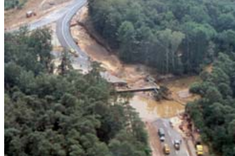
Die Bundesstraße 4 wurde am Stadtrand von Lüneburg durch die Gewalt der Fluten teilweise unterspült und schwer beschädigt, Foto: mg
