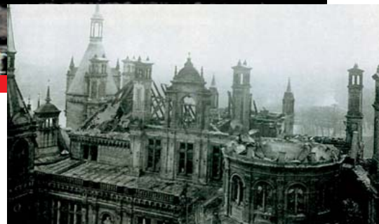
Dach des Schlossgartenflügels nach dem Brand, Foto: Landesbauamt Schwerin
