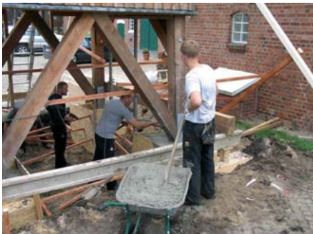
Fundament des Schlauchturms, Foto: FMSH
