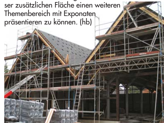
Juli 2007: Einrüstung des Gebäudes für die Eindeckung des Daches, Foto: FMSh
