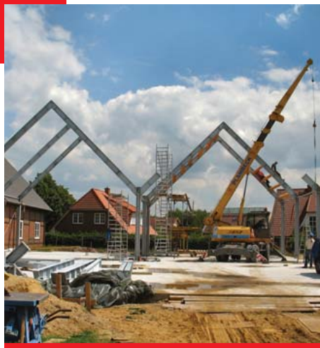
Mai 2007: Verschraubung der Stahlträger, Foto: FMSh
