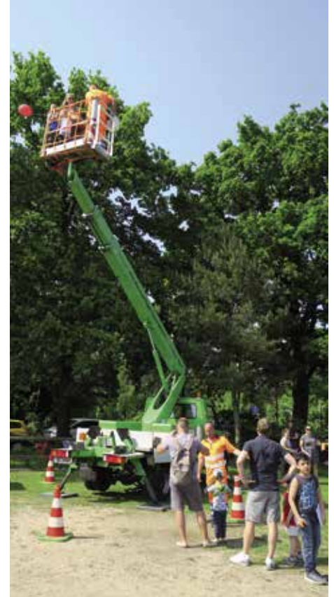
Teleskopmastfahrzeug des Betriebsamtes
